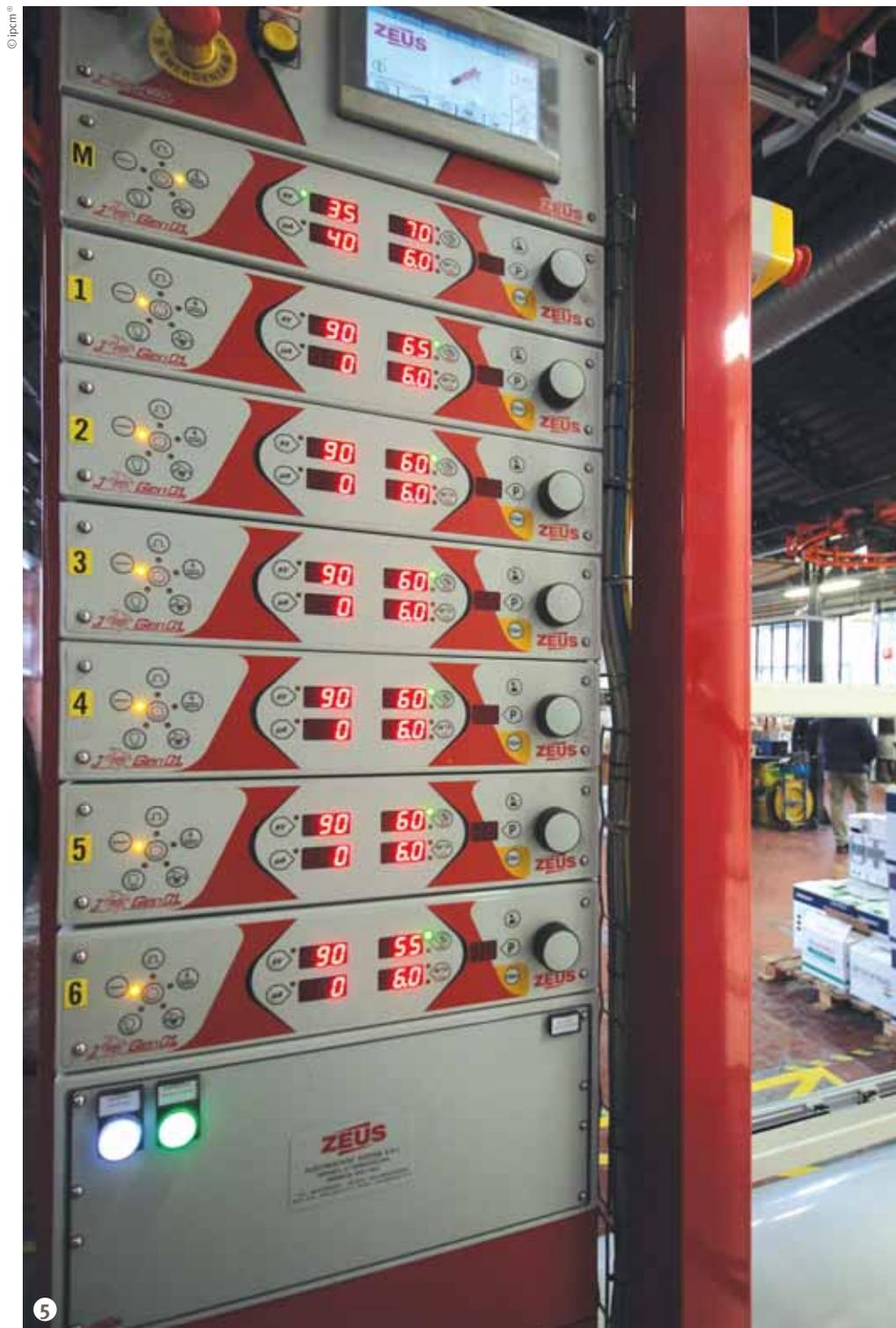
Figura 5: I moduli di controllo delle 6 pistole automatiche e quella manuale
